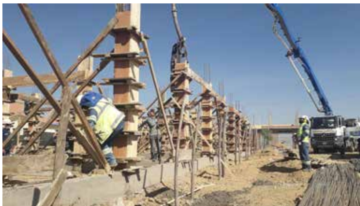
les gros oeuvres en cours
