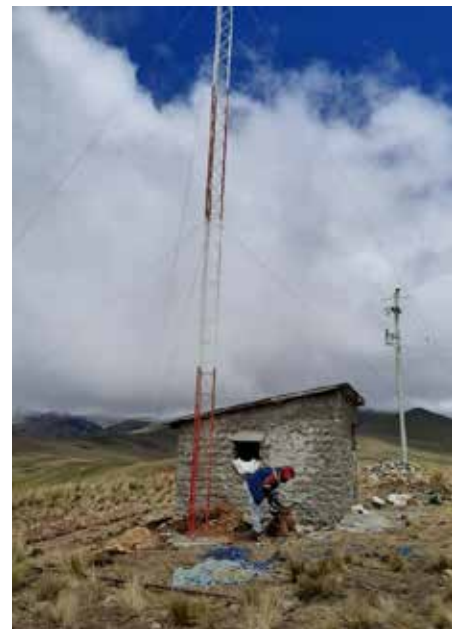
Bau einer Radio-Sendestation für den Fernunterricht während der COVID-Pandemie
