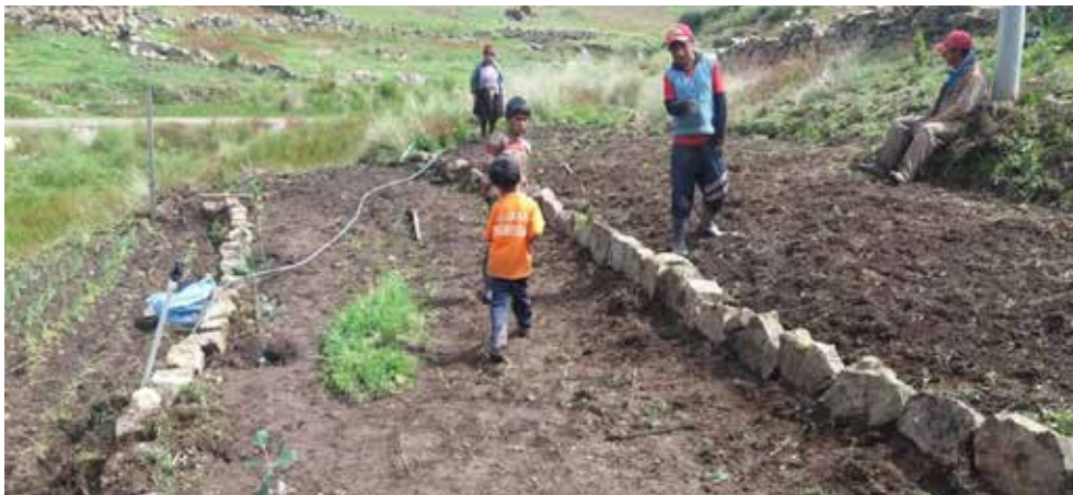
Maßnahmen gegen Bodenerosion
