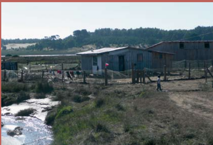
Diese küstennahen Fischerwohnungen wurden alle überflutet, hielten dem Tsunami aber stand. Großer Schaden entstand jedoch durch die zurückbleibenden Schlamm-massen
